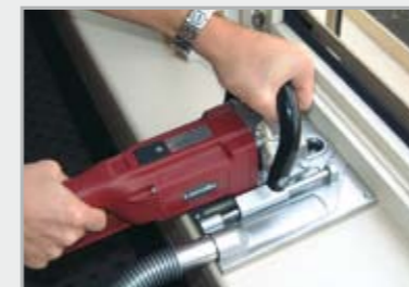
Zaagsnede in het houten raam
