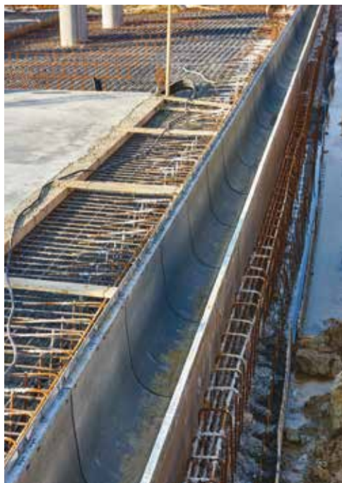
Collinet a fourni un séparateur hydrocarbures 60 l/s en PE double paroi
